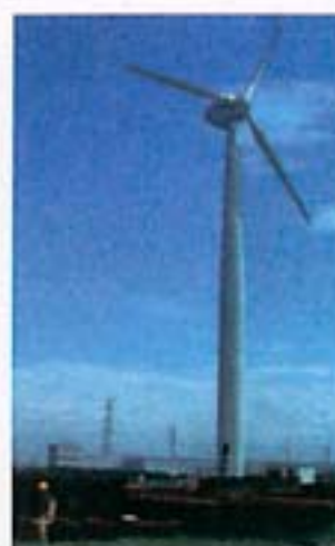
富津工場に建設された実証機「ブレードの回転軸は300kW
