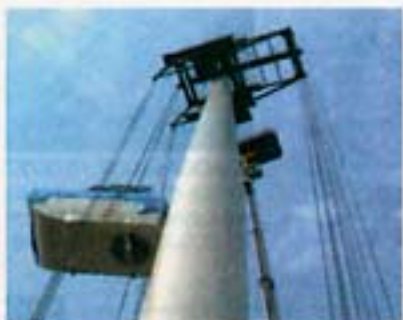
タワー頂部に独自開発した架設装置(誘導用治具)を設置し、そこにワイヤーをわたしてナセルを引き上げる。大型クレーンは必要ない
